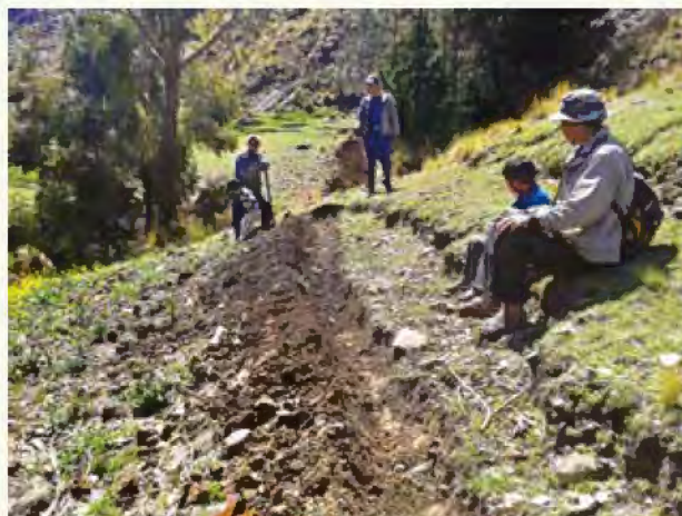
Foto: Las zanjas de infiltración deben ser realizadas en curvas de nivel
